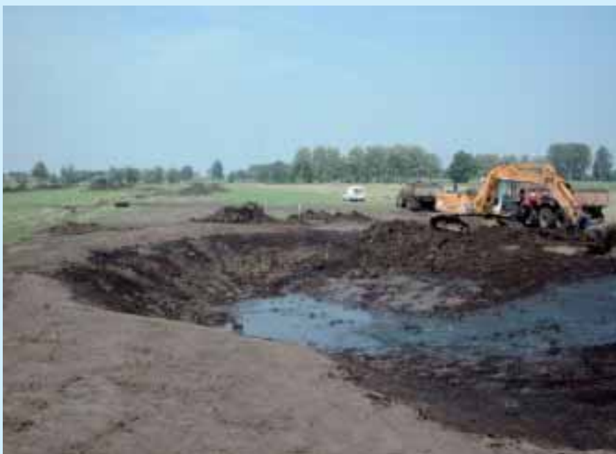
Aanleg van een poel
